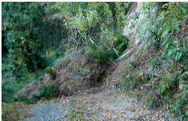
道路被害② 林道折松一天王線
