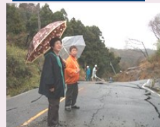
溝口市議と上登戸の崩落調査
