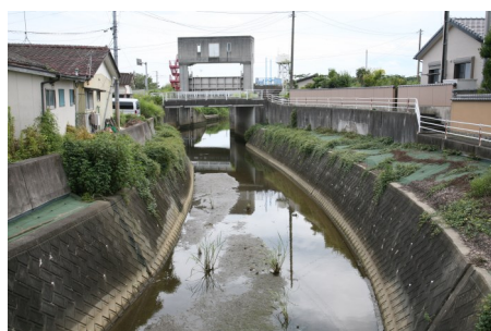
鮫川との接続水門とポンプ場
