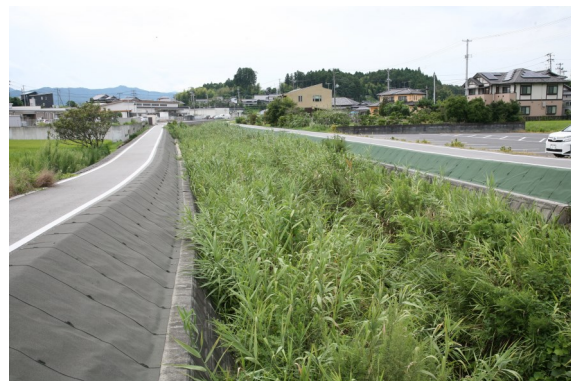
報徳幼稚園駐車場より下流域の植生が、堤防の高さを超えるほど成長し、大雨時に越水の原因になると心配されている。県では早期に除草作業をする方針と回答。
