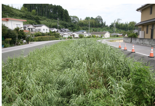
報徳幼稚園駐車場より下流域の植生が、堤防の高さを超えるほど成長し、大雨時に越水の原因になると心配されている。県では早期に除草作業をする方針と回答。
