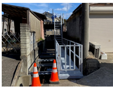
改修された横町の可動式水門。
