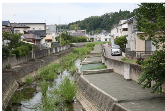
天神橋から上流、堆積土砂の撤去済み。新たな植生が見られる。
